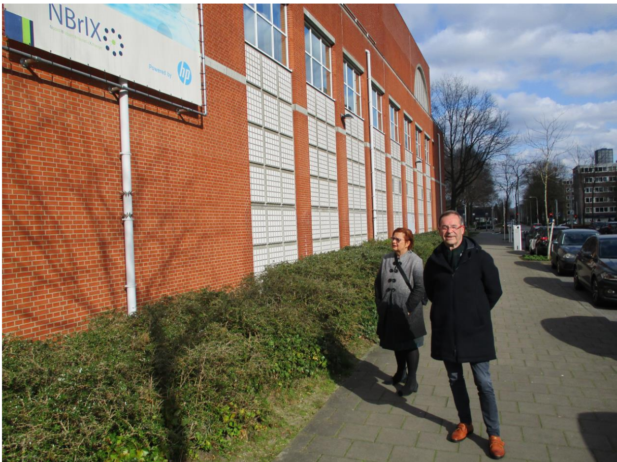
Yvonne van den Ende en Frank Pulskens bij het voormalige datacenter van Interpolis aan de Prof. Verbernelaan (foto: Aldert van der Burg)
